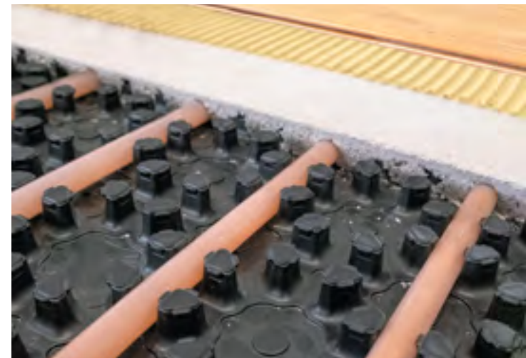
▲ Kunststof platen aan de ondervloer verbonden
