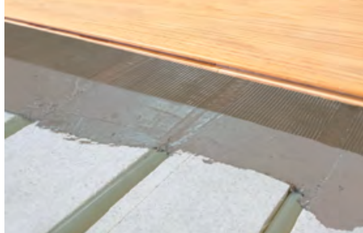
▲ Infrezen van de bestaande dekvloer
